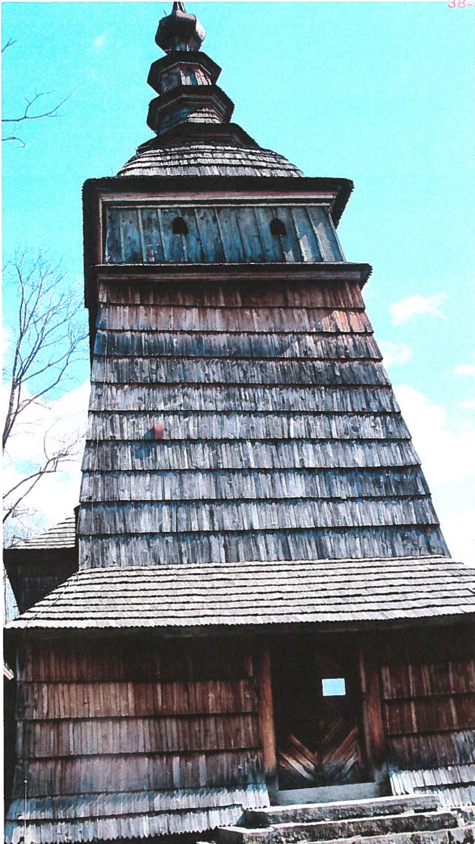
WIDOK elewacji frontowej marzec 2020 fot. J. Rotko
